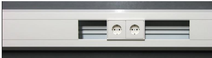
Mynd 19. Leiðslustokkur fyrir háspennu- og lágspennuleiðslur. Það ætti ekki að leiða tónmöskva um slíkan stökk samsíða öðrum leiðslum.
